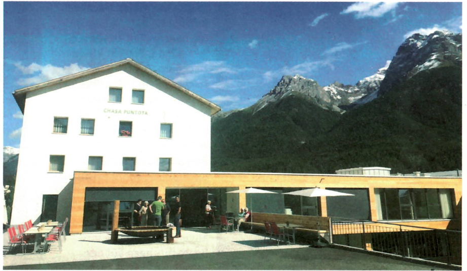
Foto: Das komplett erneuerte Alters- und Pflegeheim Chasa Puntota
